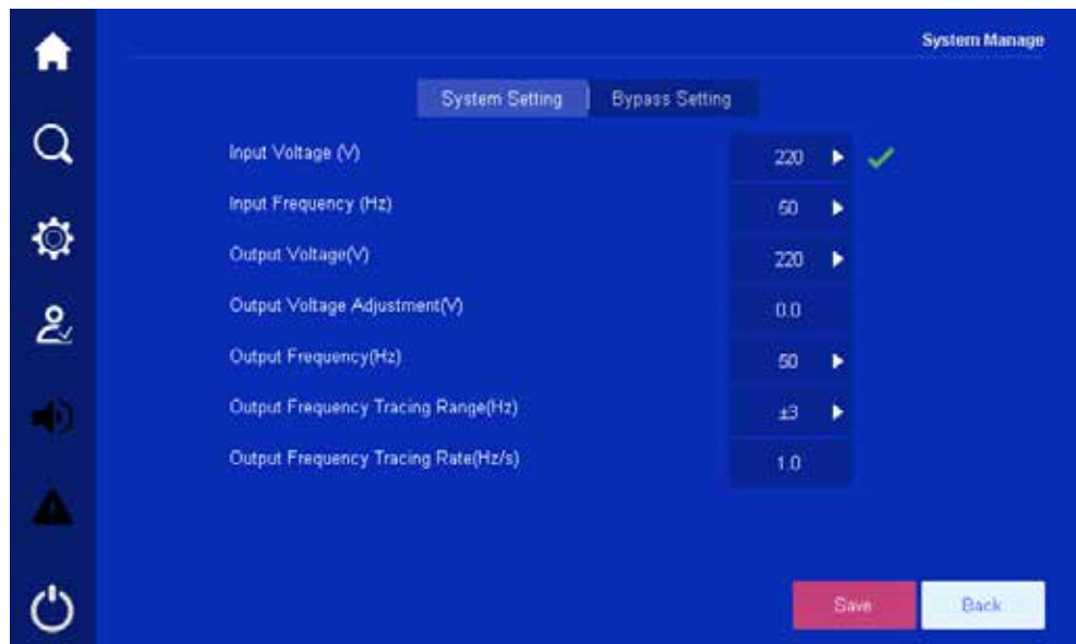
Рис. 4-26 Настройка успешно завершена
